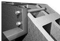
Фиксация в пустотелых блоках
