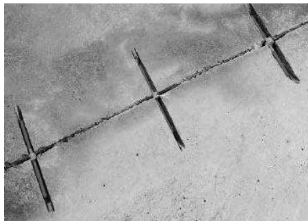
Рисунок 4. Установка стяжек в каналы, открытые в трещинах
