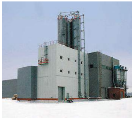
Завод BASF по производству строительной химии в России. Московская область, Подольский район
