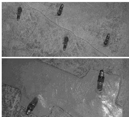
Рисунок 1. Пакеры, установленные вокруг трещины и герметизированные эпоксидным клеем серии MasterInject
