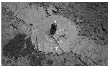
Рисунок 2. Герметизация пакера, установленного на поверхности и трещины при использовании соответствующего средства MasterInject
